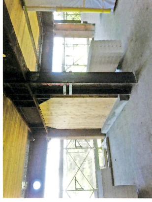
コンクリートの1/5という軽量化を活かしたCLT耐震壁
