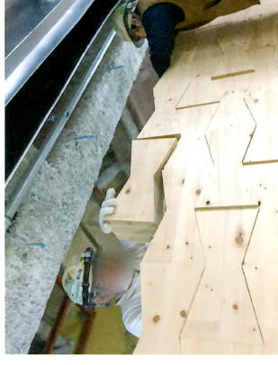
コンクリートの1/5という軽量化を活かしたCLT耐震壁
