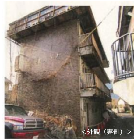
外壁、手すりが崩落した事例
