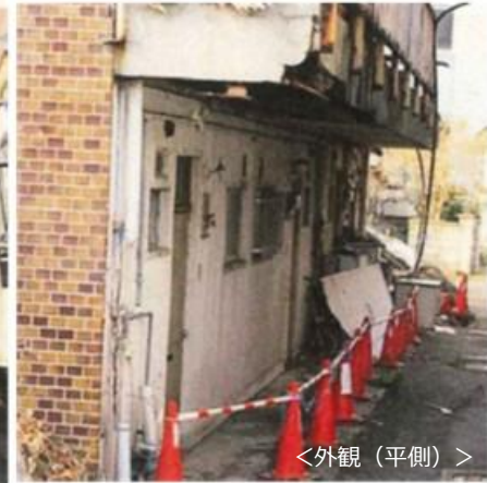
外壁、手すりが崩落した事例
