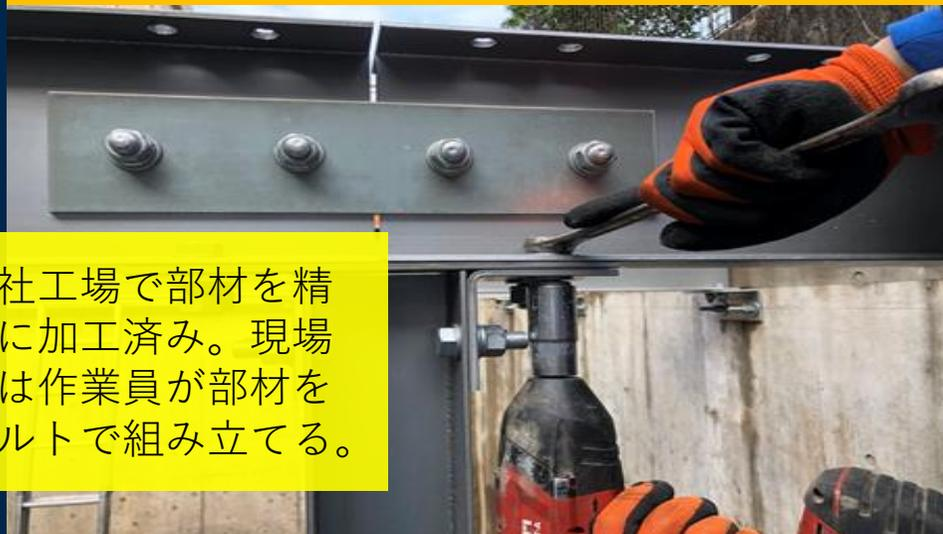
自社工場で部材を精密に加工済み。現場では作業員が部材をボルトで組み立てる。
