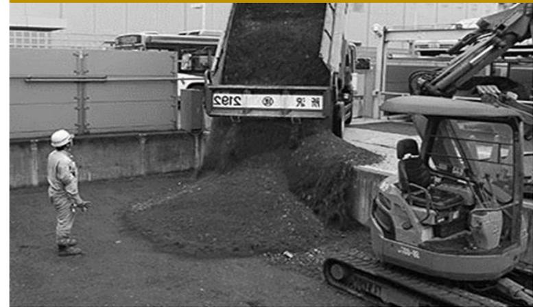
ピットを砕石で埋め、表層をアスファルト、コンクリートで覆う工法。
