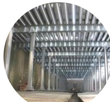
地下ピット内は、雨水が流れ込み、換気が悪いので鋼材にとって非常に過酷な環境です。
