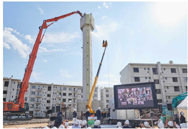
石神井公園団地のシンボル 給水塔の解体
